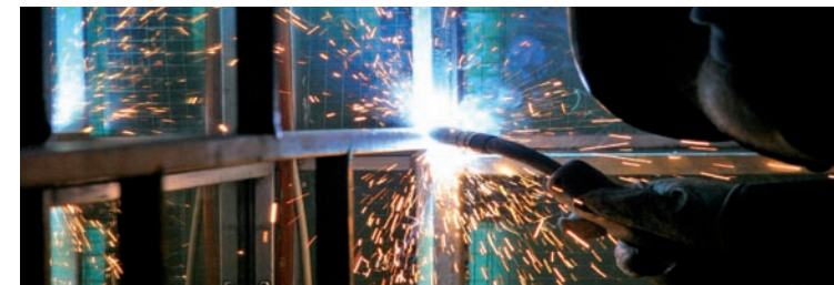
Trabajo de reparación
