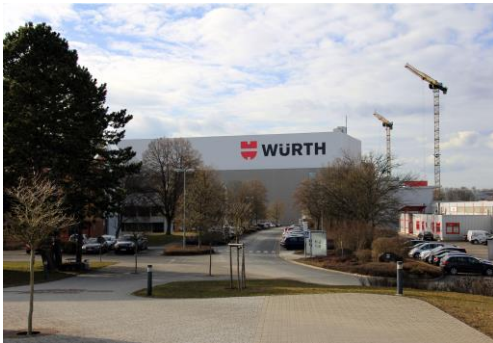
Picture 1: Baumaßnahmen Industriepark Würth.jpg
